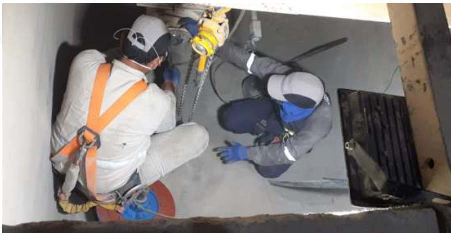
Figura 2. Atividade de troca de um moto redutor. Fuente: Autoria Propria,2025
