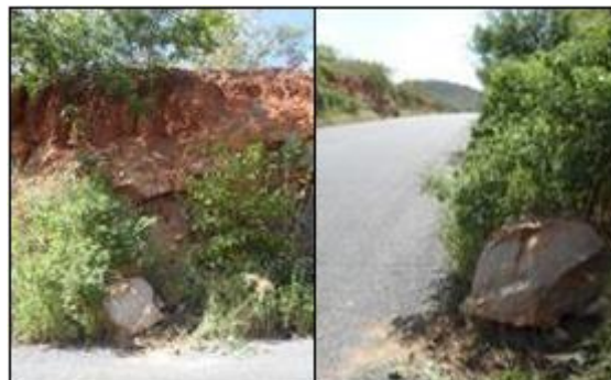
Figura 10. Bloco de rocha entre a vegetação (BR-226). Fonte: autores (2017).
