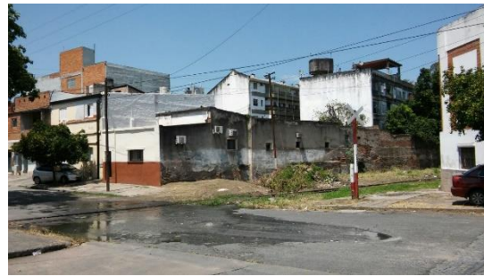
Figura 10. Aguas servidas superficiales en la intersección de las vías con calle Marcos Paz (*)
