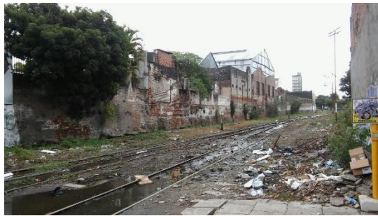
Figura 9. RSU en la intersección de las vías ferroviarias con calle Santiago del Estero (*)
