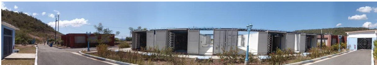
Figura 1: Planta Desalinizadora "Boca de Cabañas". Fuente: Elaboración propia.
