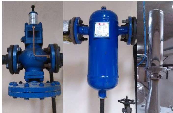
Figura 7. Válvula reguladora, trampa de vapor y filtro de venteo.
