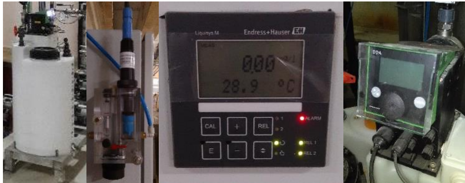
Figura 9. Elementos del lazo de control de pH.
