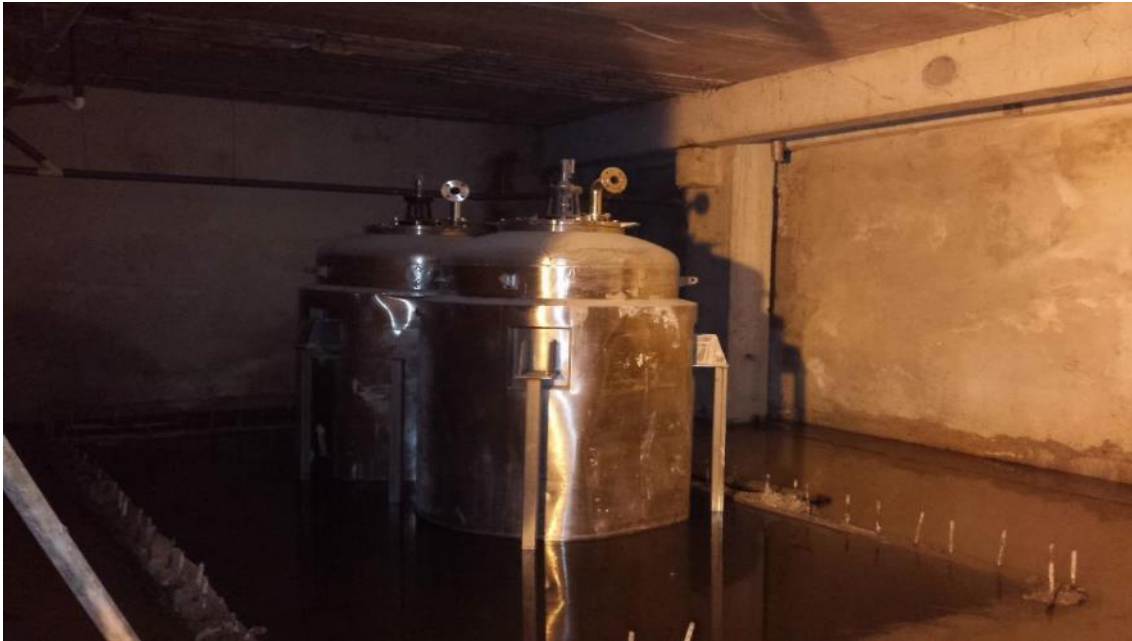
Figura 2. Condiciones iniciales del local
