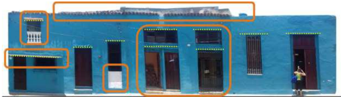
Figura 3. Panorámica de la vivienda 105, 107, 109, 109B, 109A, 109 Altos. (Residencia de Ignacio Ernesto Agramonte Simoni). Transformaciones en fachada.
