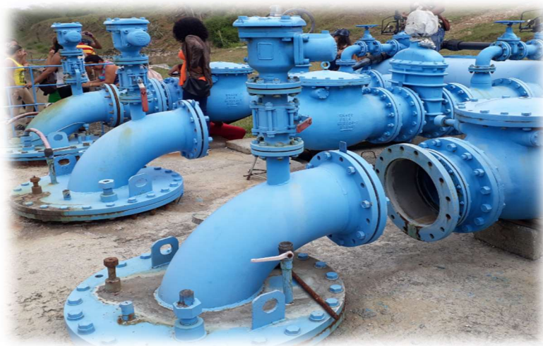
Fig. # 5 Instalación de una Estación de Bombeo de gran envergadura.
