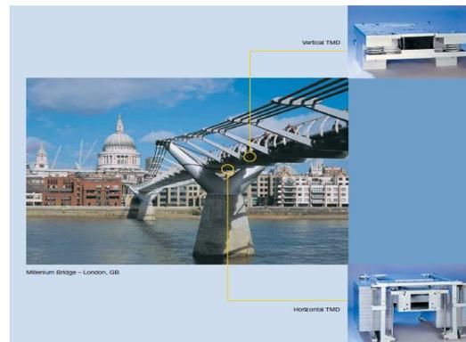
Fig.2.1.TMD en el Puente London Millennium.UK(GERB, 2007)
