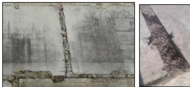
**Figura 5. Erosión de juntas en el cuerpo de la estructura**
