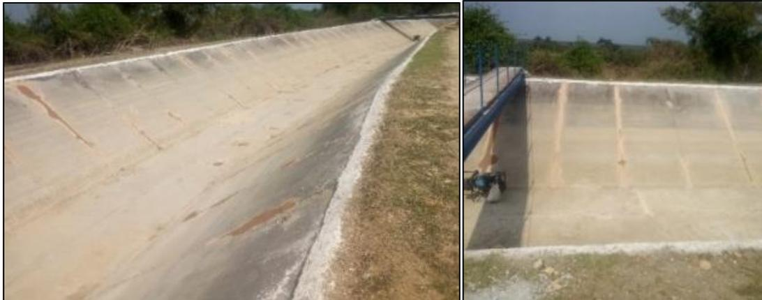
*Figura 3.7. Canal con Juntas reparadas.*
