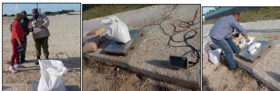
**Figura 3.1. Pesado de los materiales a usar en el mortero.**
