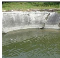
*Figura 2 Agrietamiento en canales*
