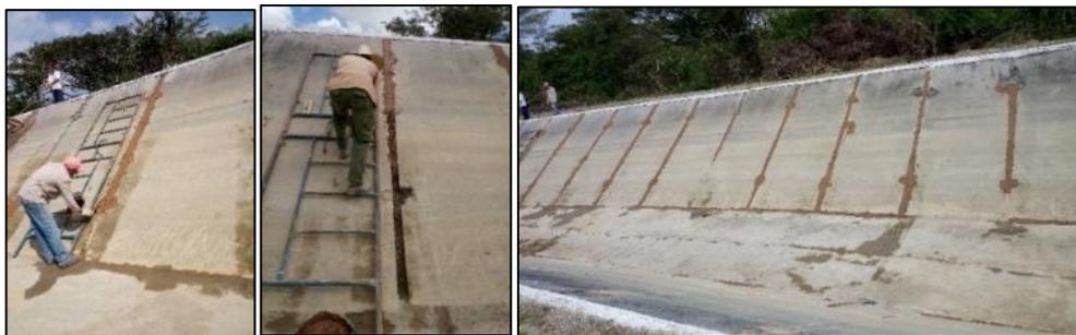
*Figura 3.6. Colocación del mortero en las juntas del canal.*
