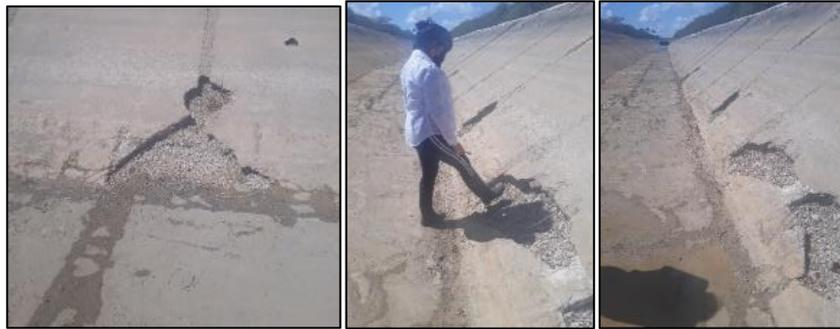
**Figura 3. Erosión de la superficie en el cuerpo de la estructura**
