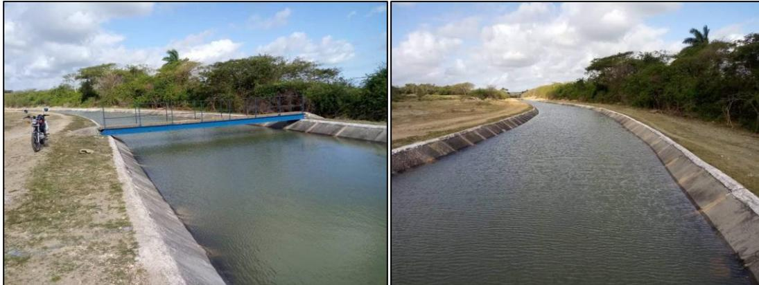
*Figura 3.7. Canal con Juntas reparadas.*
