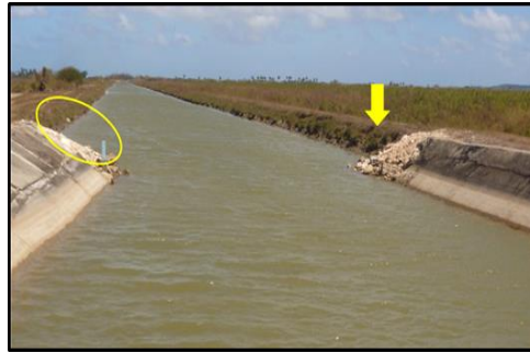
Figura 4.1: Deformación de la sección transversal del canal
